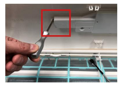
3. Отверткой с плоским жалом подденьте язычок корпуса дисплея, сдвиньте отвертку влево и выведите язычок из зацепления.
